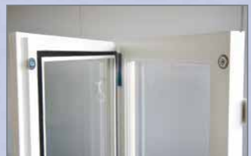
Flügel wird mittels Magneten gehalten
